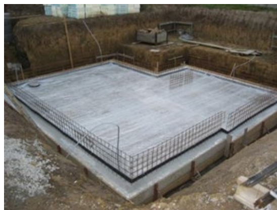
Frische Betondecke am Bau
